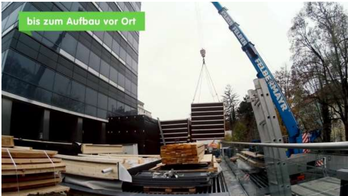
(Abb. 11 in Minute 00:39) (Aufbau Kran)
